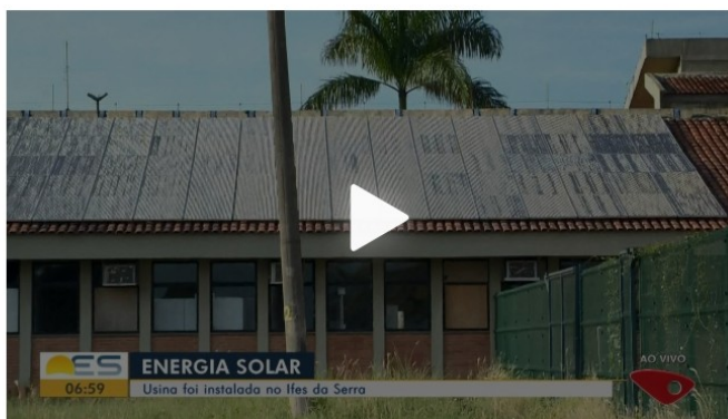
Usina de energia solar é instalada no Ifes da Serra
